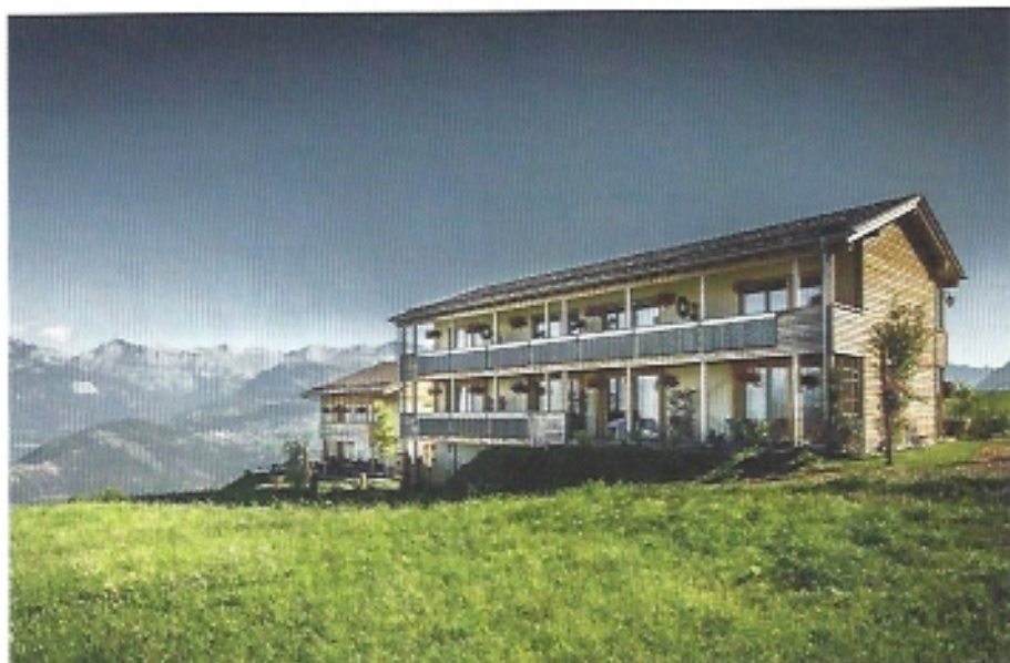
Im Maya Boutique Hotel in Nax-Mont-Noble (VS) bestehen sowohl die Aussenwände als auch die Innenwände zwischen den acht Zimmern aus 80 Zentimeter breiten Strohbällen.
